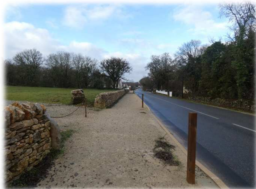
Exemple d'entrée de village sur la commune de Rocamadour avec une connectivité paysagère et écologique
