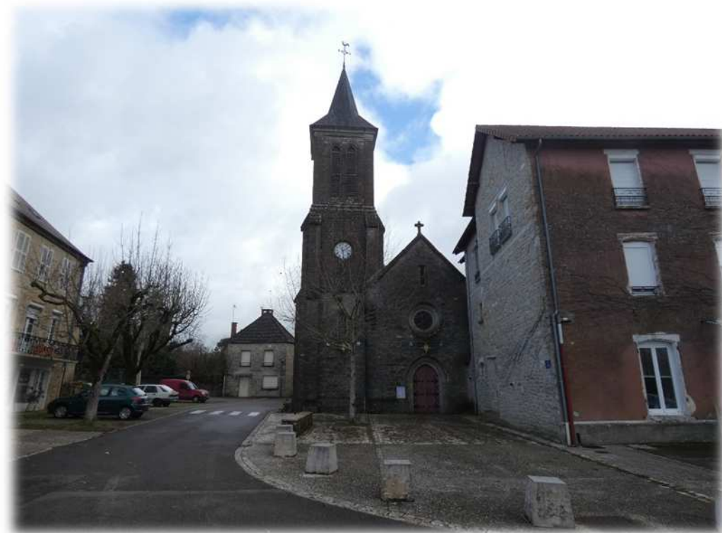
Clocher de l'église d'Alvignac, pour lequel les combles pourraient être protégés
